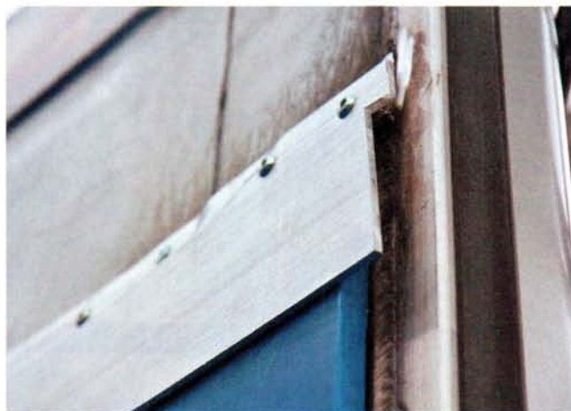
Верхняя кромка вкладыша должна быть надежно зафиксирована. Это можно сделать, например, куском дюрала
