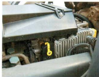
Блок управления двигателем смонтирован с левой стороны дизеля
