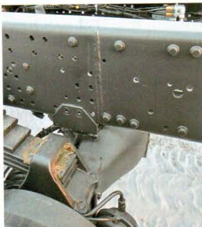
В этом месте лонжерон рамы сварен, но внутри установлены усилители
