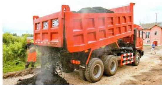
Для работы с асфальтоукладчиком сзади кузова нужен козырек. Но порой раскидывают лопатой
